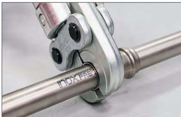
Assemblaggio attraverso pressatura / Making the press connection
