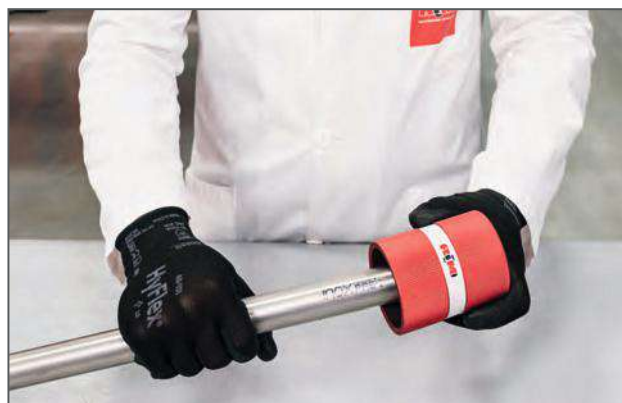
Sbavatura del tubo / Deburring the pipe
