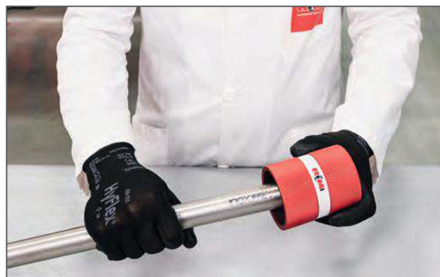
Sbavatura del tubo / Deburring the pipe
