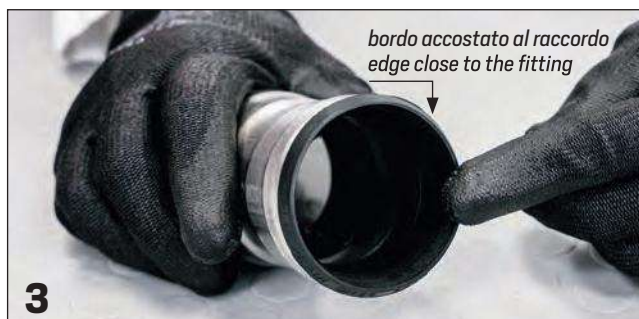
Verificare posizionamento guarnizione / Verify the correct gasket's position
