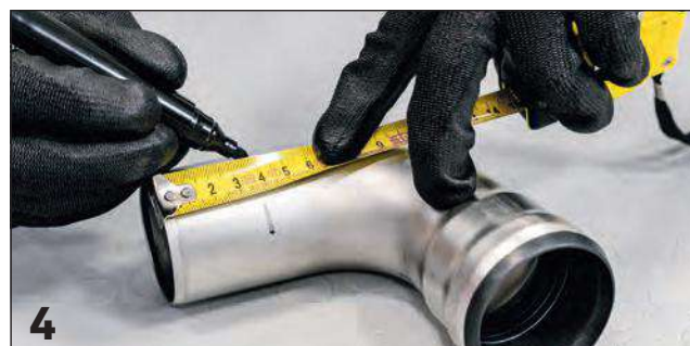
Marcatura quota d'innesto / Marking the insertion's depth
