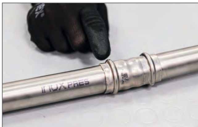
Controllo della pressatura / Checking the press connection
